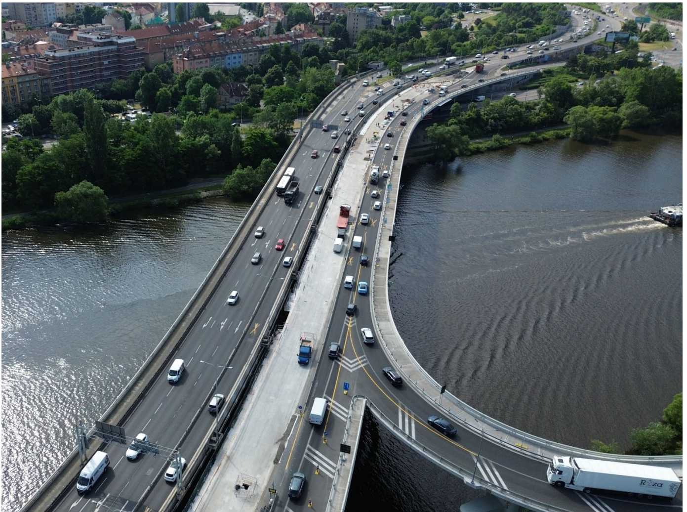
Obrázek 14: Pohled na rekonstruovaný Barrandovský most od západu
