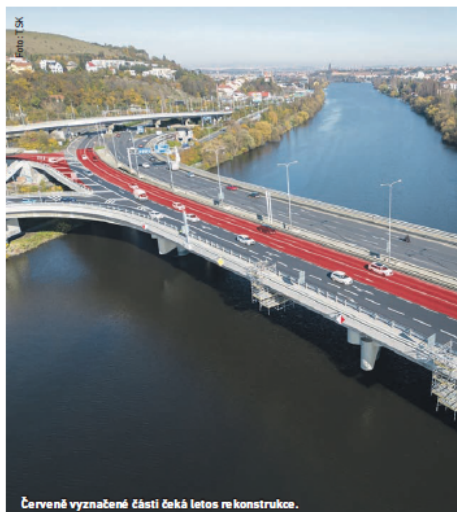
Červeně vyznačené části čeká letos rekonstrukce.
