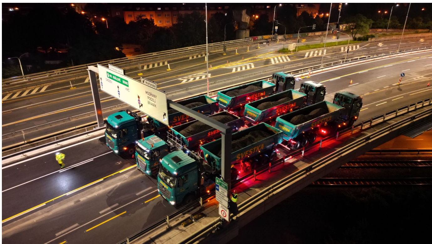
Obrázek 2: Zátěžová zkouška Barrandovského mostu
