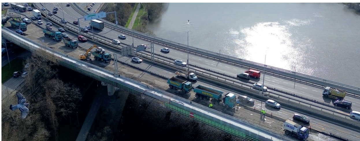
■ Průběh 3. etapy rekonstrukce
