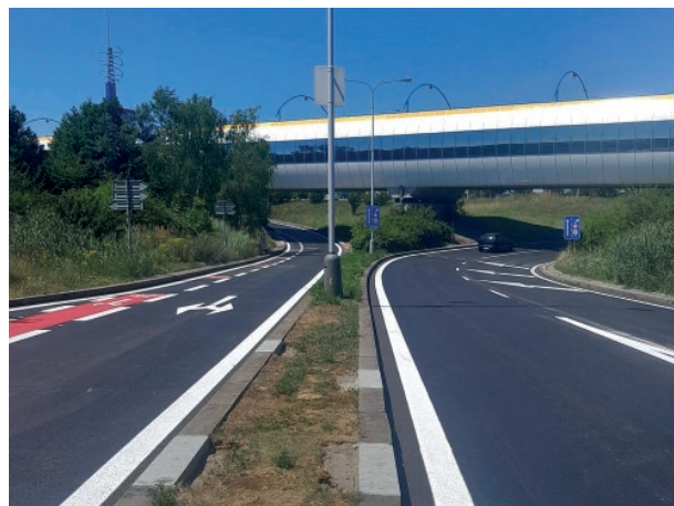
■ Rampy Chlumecké pod tubusem metra
