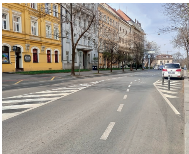
■ Hlavní dopravní prostor po rekonstrukci
