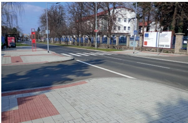
■ Ulice Beranových po rekonstrukci
