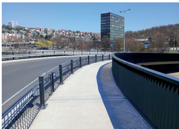
■ Opravená rampa mostu Barikádníků
