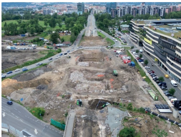
■ Libeňské soumostí v průběhu bouracích prací
