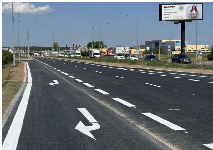
■ Rekonstruovaný jízdní pás před zprovozněním
