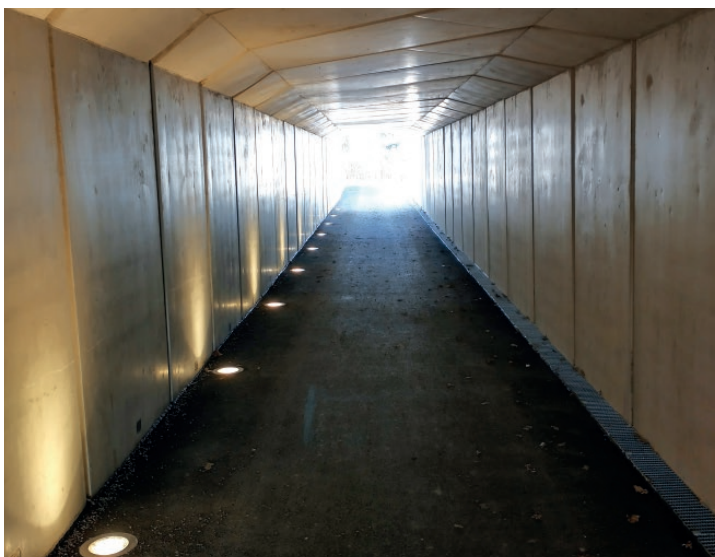
■ Interiér podchodu s nepřímým bodovým osvětlením
