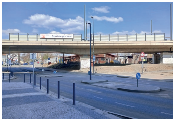
■ Nová mostní estakáda místo původního úrovněového přejezdu
